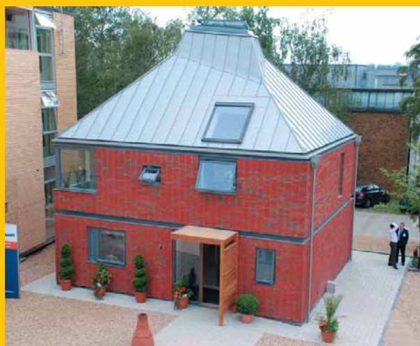
Inghilterra, Watford, Garston. Hanson Eco House. Architetto Mark Stewart TP Bennet. Questo edificio, costruito per il BRE Offsite 2007, è un prototipo sperimentale in vista dell'obiettivo "Zero Carbon" (ossia "zero emissioni di CO 2 ") nel 2016, prefissato dall'Inghilterra. L'edificio è costituito da un sistema prefabbricato di pannelli di 9 metri per 3 metri in blocchi di calcestruzzo interni, mattoni faccia a vista esterni e isolante in intercapedine. L'edificio ha l'obiettivo di dimostrare il ruolo della massa termica e della ventilazione naturale negli edifici a basso consumo energetico.
