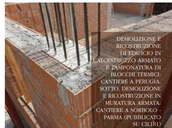
DEMOLIZIONE E RICOSTRUZIONE DI EDIFICIO IN CALCESTRUZZO ARMATO E TAMPONATURA DI BLOCCHI TERMICI: CANTIERE A PERUGIA. SOTTO, DEMOLIZIONE E RICOSTRUZIONE IN MURATURA ARMATA: CANTIERE A SORBOLO - PARMA (PUBBLICATO SU CIL181)
