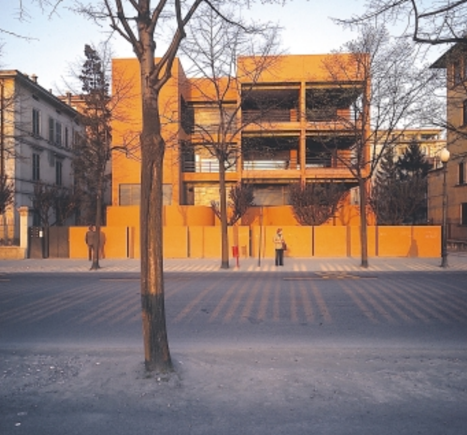
Palazzina sul LungoParma. Il prospetto principale su viale Basetti (foto: Guido Canali).
