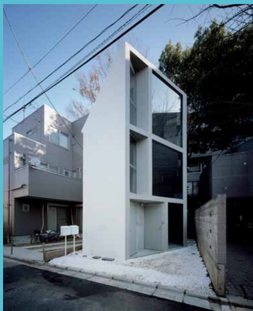
63.02°. È una piccola costruzione progettata dallo studio Sschemata, composta da due unità abitative, edificate su una superficie di soli 24,58 m 2 , in Nakano, Tokyo. ©2010 Takumi Ota Photography
