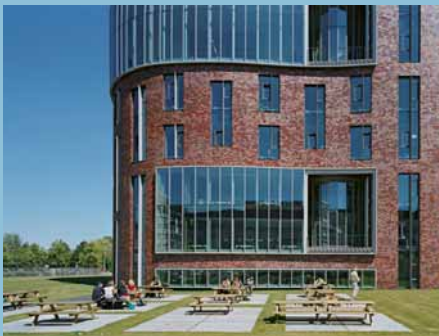
Serramenti continui a sbalzo.
