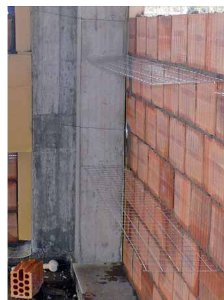
8. Predisposizione di fogli di rete metallica come sistema di graffaggio (foto: Michele Destro).
